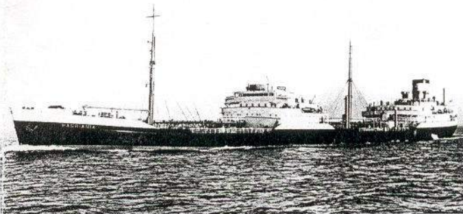
De stoomturbinetanker „Hadriana”, gebouwd in 1954 door Smith's Dock, South Bank voor Shell Tankers Ltd., Londen. Het schip mat 12.160 brt, 18.100 dwt. De „Hadriana” behoorde tot de grote serie Shelltankers van de „H”-klasse”, identiek aan de Nederlandse tankers van de „K”-klasse. Foto Shell Tankers Ltd., Londen.
